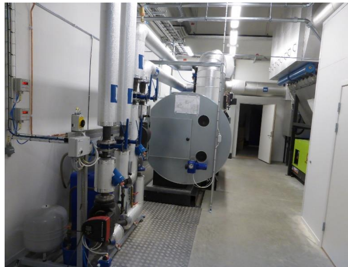
Pumpstativet, rökgaskylare och filter med generator
